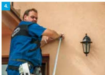
4. Vermessung des Installationsorts für die Schienenanlage an der Wand
